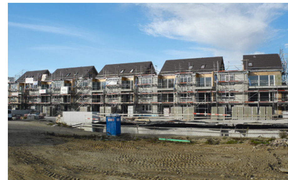
▲ Die Alterssiedlung im Bau.
